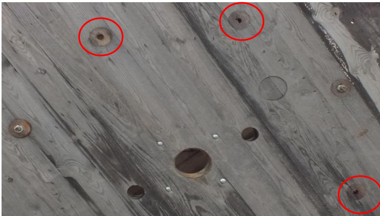
KUVA 5, MO = METALLIOSIA PUUTTUU
